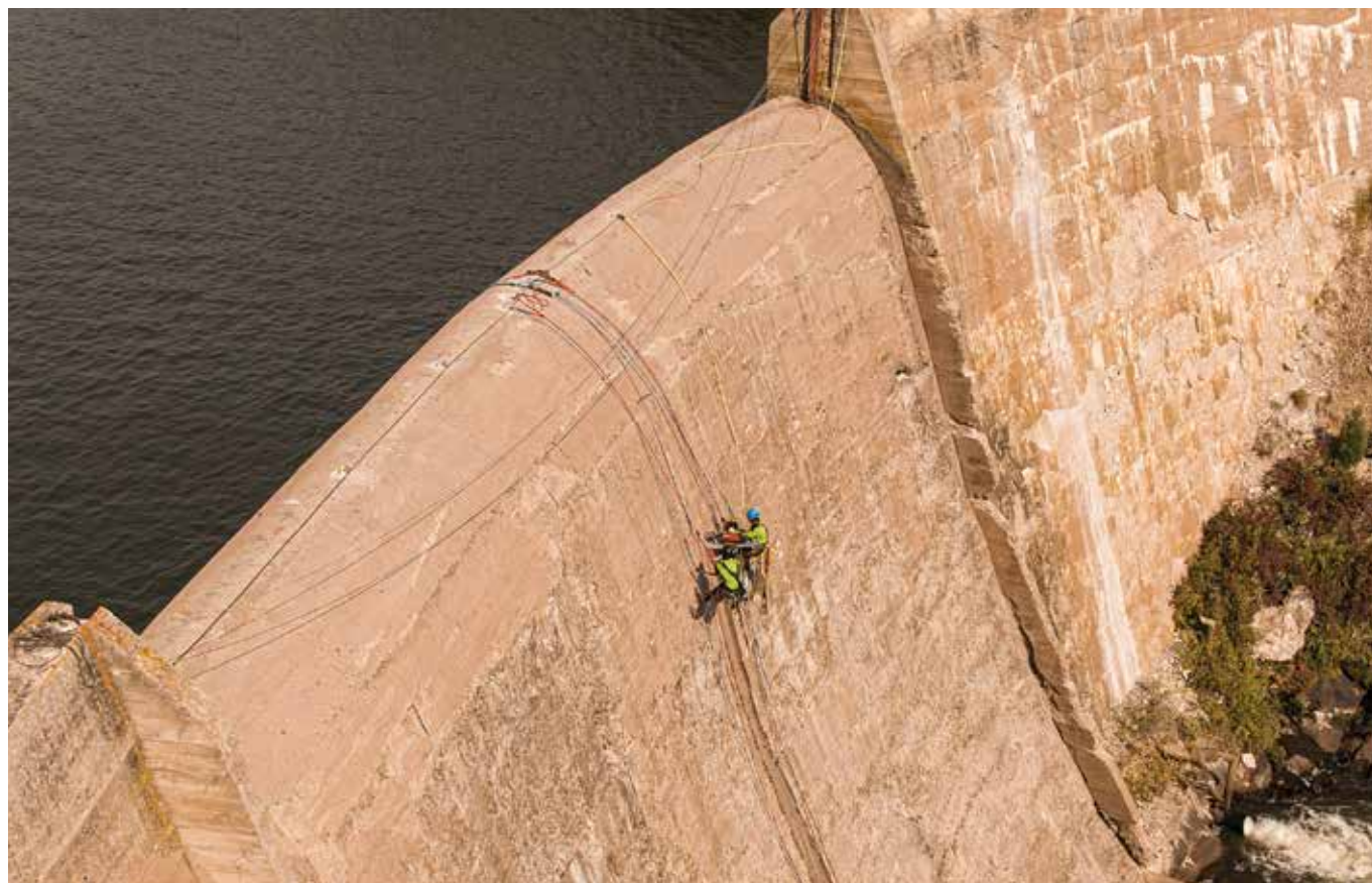
Extracting 4-foot long 6-inch diameter core samples from the Halligan Dam. Extracción de muestras de 15cm de diámetro y 1.2m de largo en la presa de Halligan. Colorado, U.S.A. (courtesy of Master Point Rope Access Solutions, ph. Chris Alstrin).
