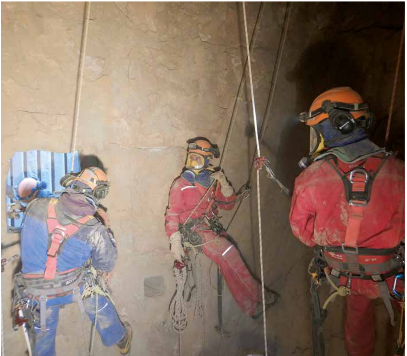
Cleaning operations on a cement plant. Operaciones de limpieza en una torre de una planta de cemento. Péry, Switzerland (courtesy of Corde-Access SA).
