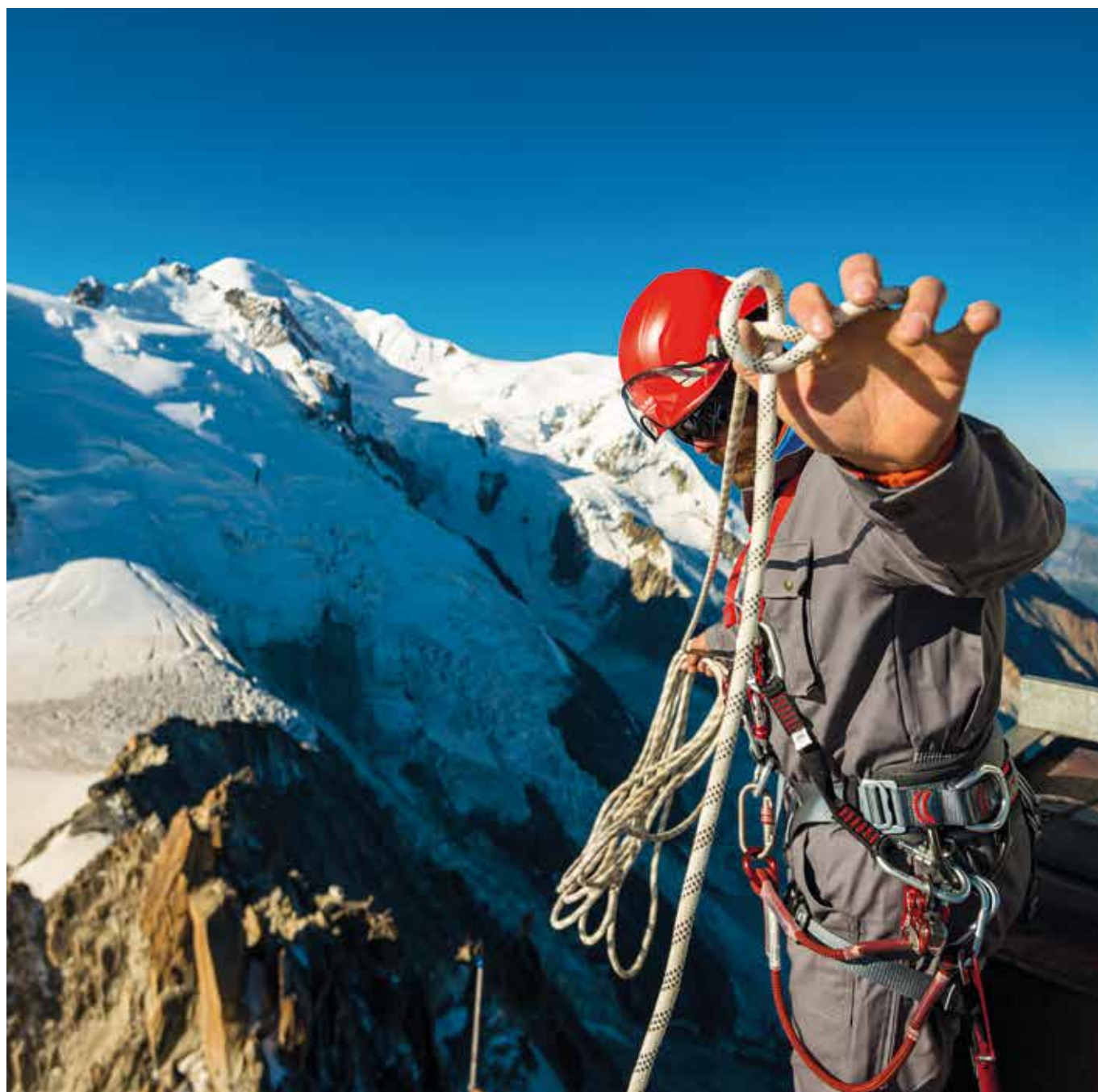
Preparation of rope before rock scaling operations on the walls of Mont Blanc. Preparación de cuerdas para trabajos de aseguramiento de taludes en las paredes del Monte Blanco. Chamonix-Mont-Blanc, France (courtesy of C.A.M.P. France s.a.r.l., ph. Pascal Flamant).
