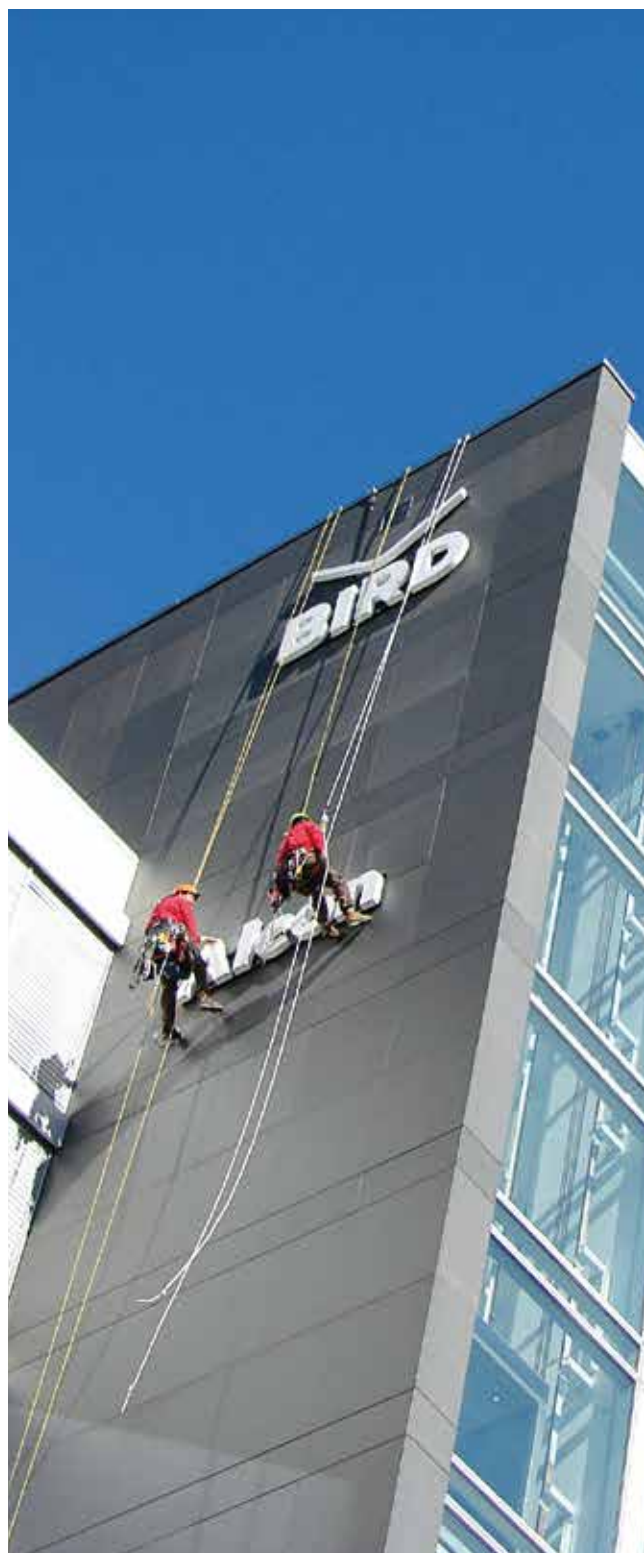
Installation of a logo on a building. Instalación de un logotipo en un edificio. Genève, Switzerland (courtesy of Corde-Access SA).
