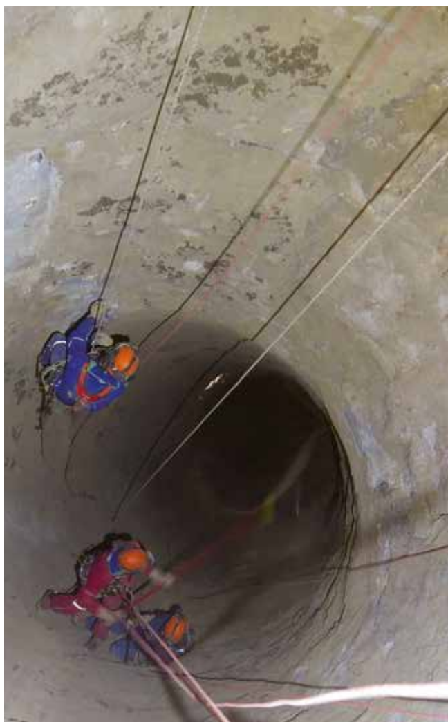
Cleaning operations on a cement plant. Operaciones de limpieza en una torre de una planta de cemento. Pèry, Switzerland (courtesy of Corde-Access SA).
