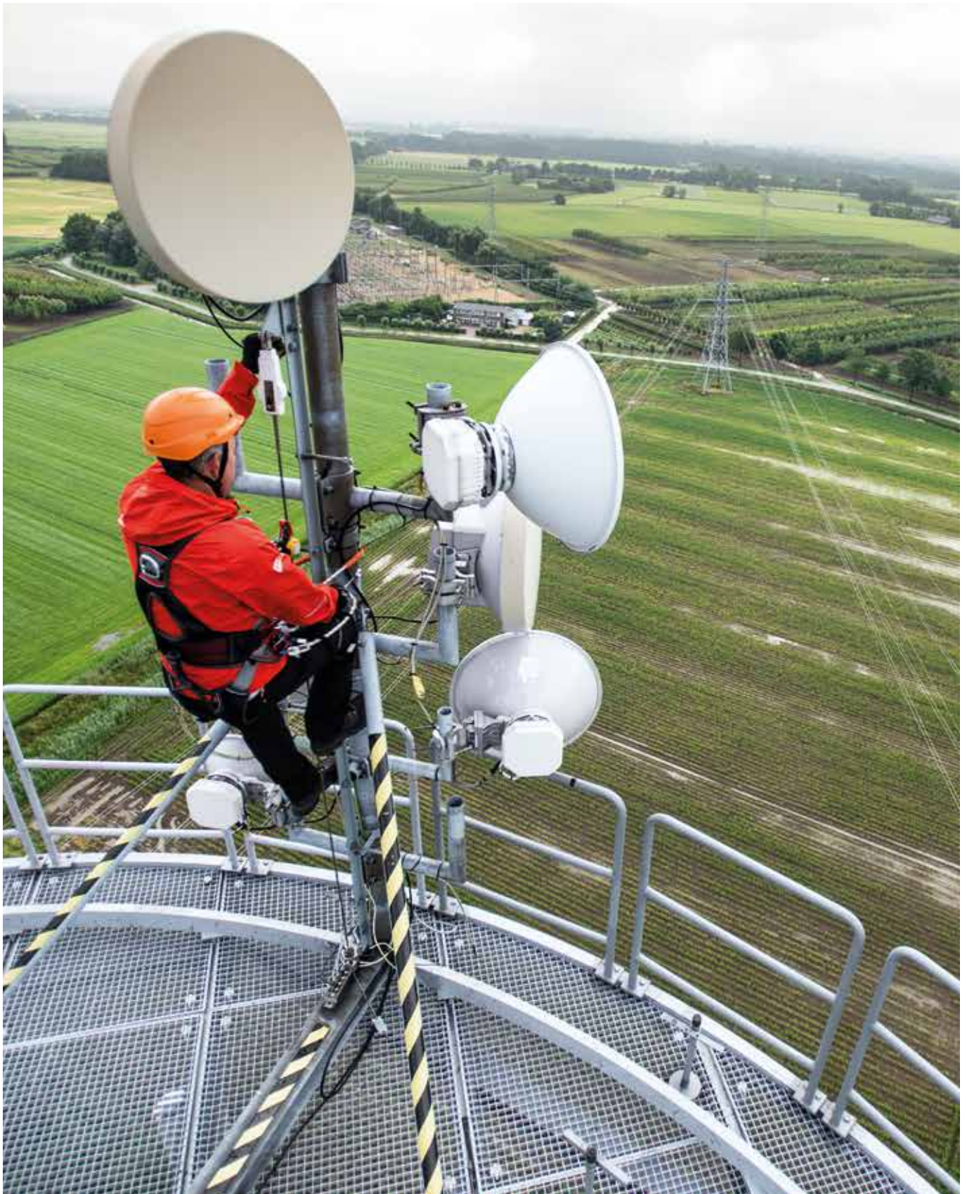
Inspection of permanent fall protection systems on a shared NOVEC mast. Inspección de los sistemas de protección permanente anti-caídas en una torre NOVEC. Dodewaard, The Netherlands (courtesy of Unispect, ph. Riky Felderer).
