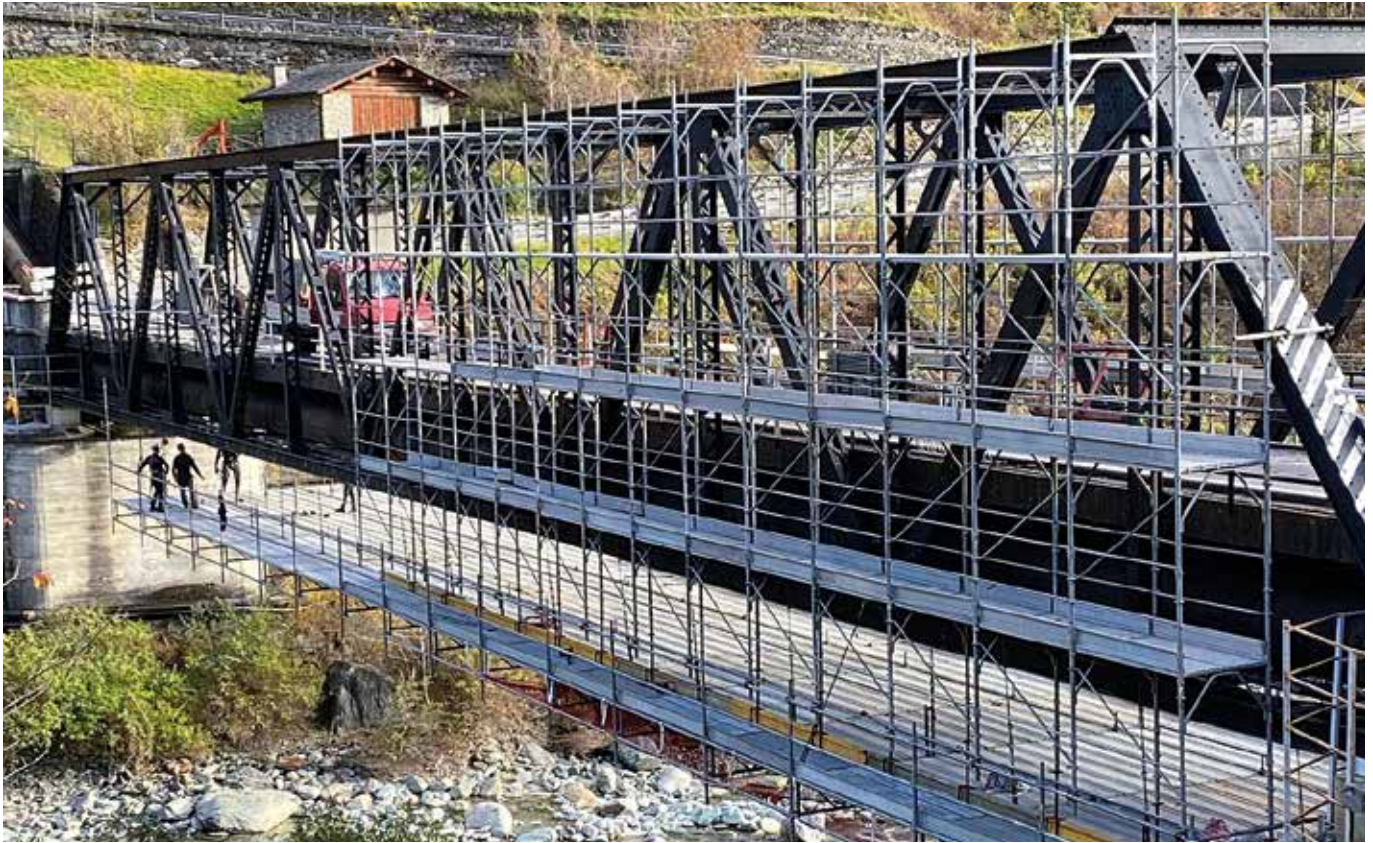
Mounting scaffolding for the maintenance of a bridge. Instalación del andamiaje para el mantenimiento de un puente. Chiesa in Valmalenco, Sondrio, Italy (courtesy of Pielle s.n.c.).
