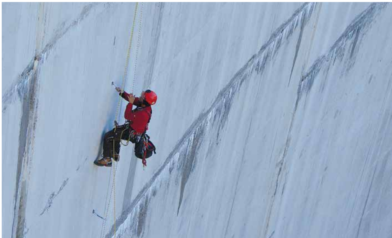
Rope access maintenance activities on the Hongrin dam. Mantenimiento mediante trabajos verticales en el embalse de l'Hongrin. Hongrin dam, Switzerland (courtesy of Corde-Access SA).
