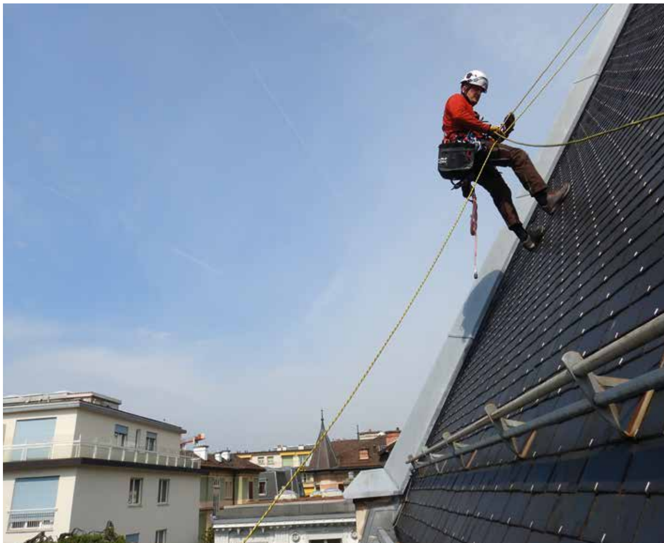
Reparation work on a roof. Trabajos de reparación en un tejado. Lausanne, Switzerland (courtesy of Corde-Access SA).
